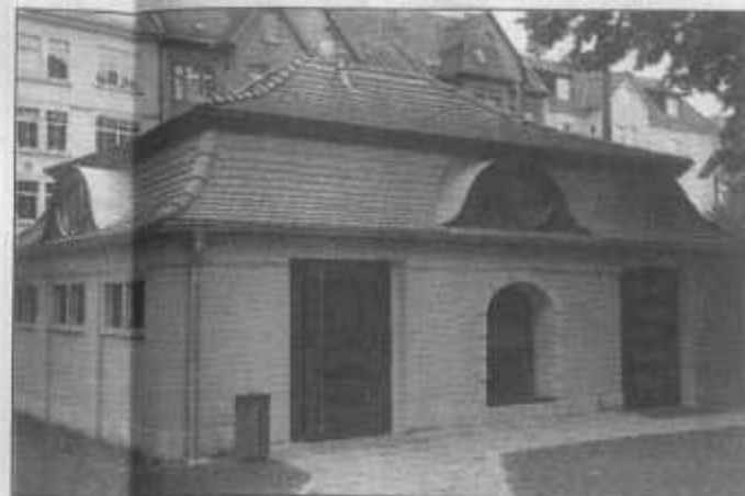
Dieses und ein weiteres kleines Gebäude auf dem Hof wurden von Grund auf saniert. Eines beherbergt jetzt das Café und eines die neue Toilettenanlage.
