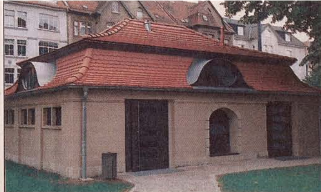
Dieses und ein weiteres kleines Gebäude auf dem Hof wurden von Grund auf saniert. Eines beherbergt jetzt das Café und eines die neue Toilettenanlage.
